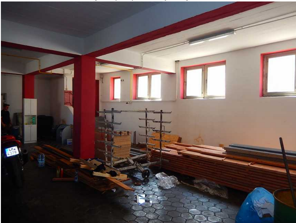
prostory dílny v 1.NP objektu č.p. 742
