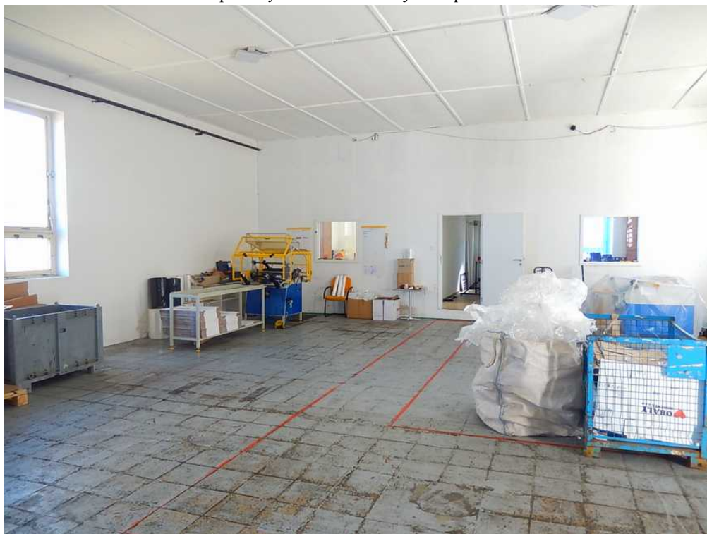
prostory skladů ve 2.NP objektu č.p. 742
