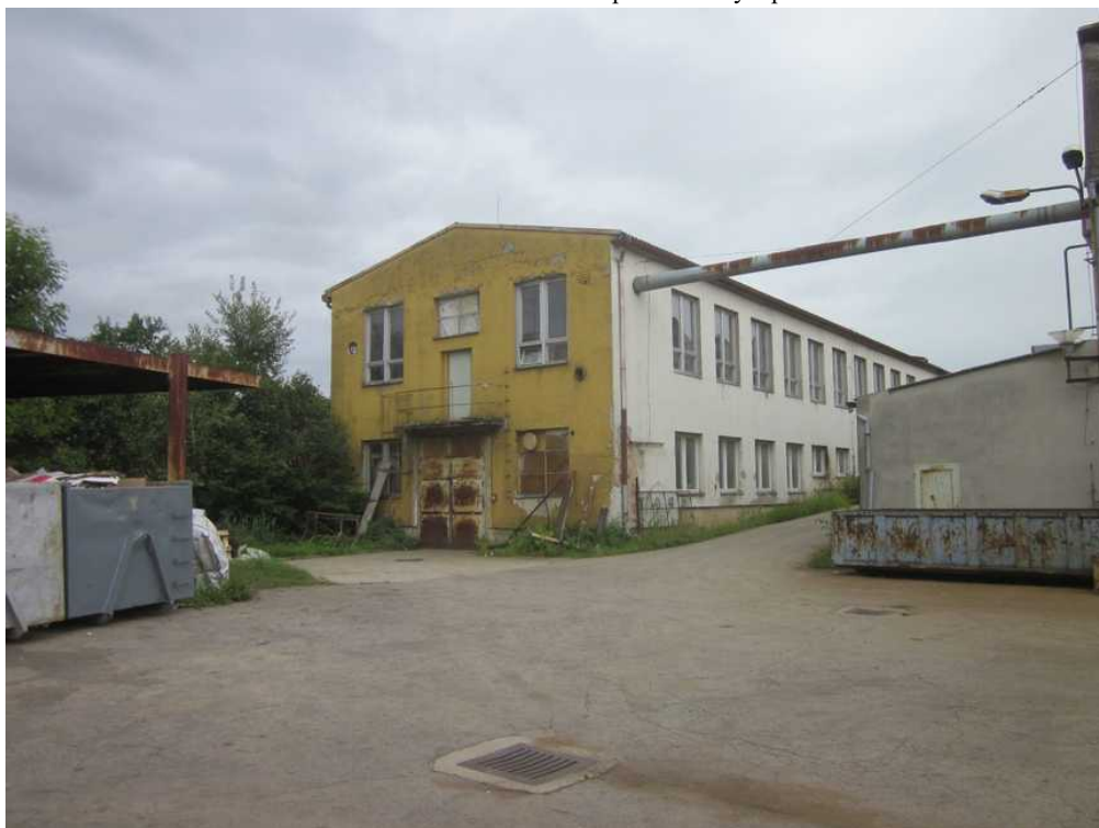
severní fasáda objektu č.p. 742
