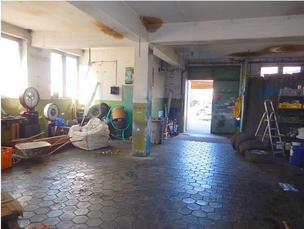
prostory dílny v 1.NP objektu č.p. 742
