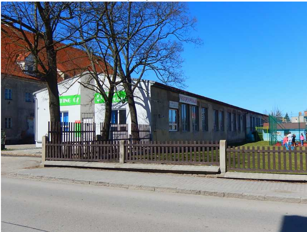
pohled na objekt č.p. 742 z Omlenické ulice
