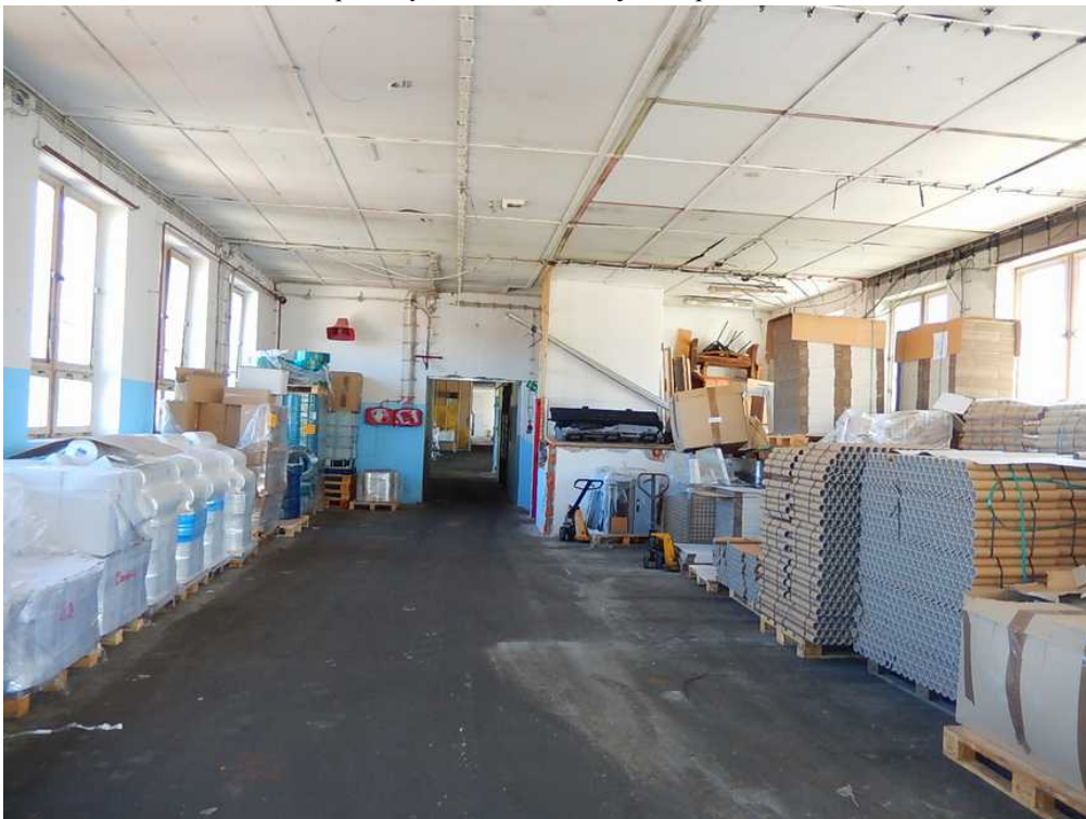
prostory skladů ve 2.NP objektu č.p. 742
