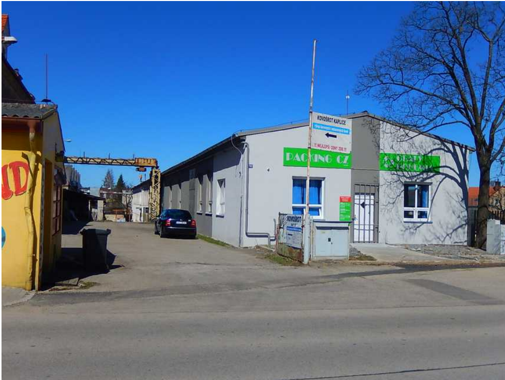
pohled na objekt č.p. 742 z Omlenické ulice
