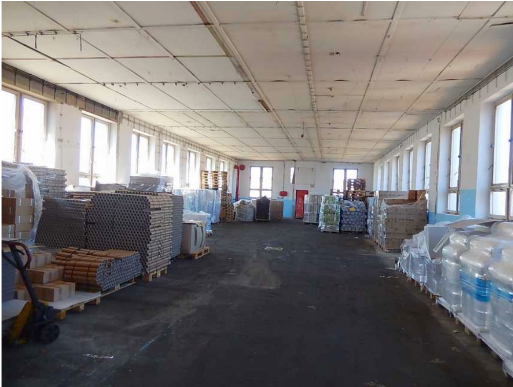
prostory skladů ve 2.NP objektu č.p. 742
